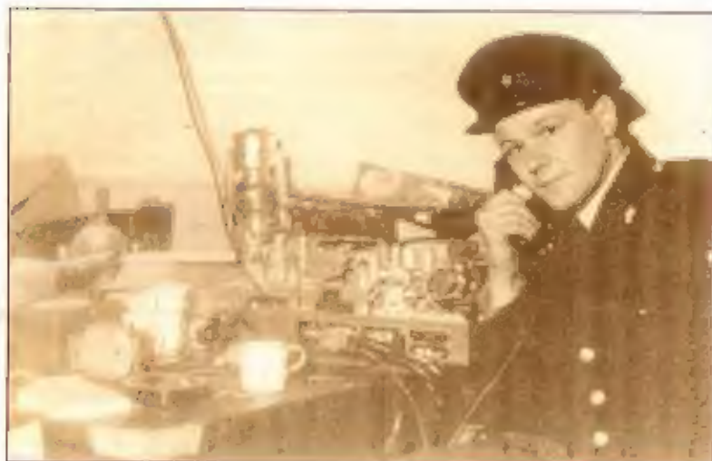
Agent van politie in het rampgebied aan de Philips SRR-192 politiemobilfoon. Opmerkelijk is dat de afdekkap van de mobilfoon is verwijderd. Gevolg van een reparatie ter plaatse of om te voorkomen dat de mobilfoon oververhit raakt door het intensieve gebruik?
